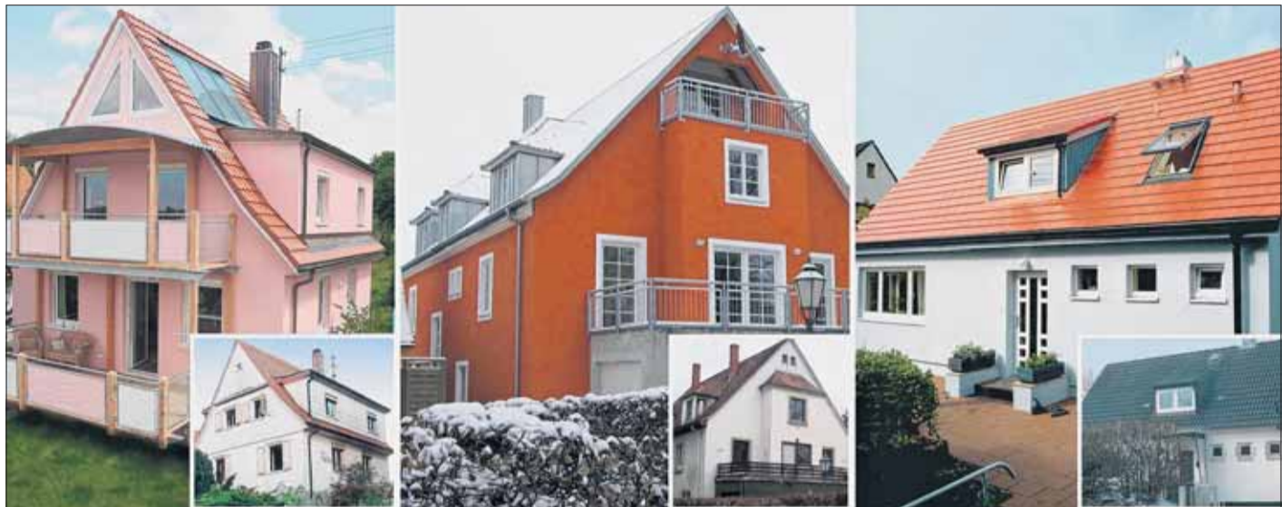
Vorher und nach der Sanierung: Durch eine grundlegende Sanierung kann man Energie und damit auch Kosten sparen und ein echtes Schmuckstück aus dem alten Haus machen.. Doch je nach Sanierungsaufwand sollten Hausbesitzer auch überlegen, ob ein Neubau in manchen Fällen nicht wirtschaftlicher wäre. Foto: STO AG
