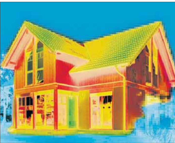
Mit Hilfe einer Wärmebildkamera lassen sich die energetischen Schwachstellen eines Hauses ermitteln. Durch bessere Dämmung der Gebäude und intelligentere Ansätze zur Energieversorgung kann man deutlich Energiekosten senken. Fotos: Schwäbisch Hall
